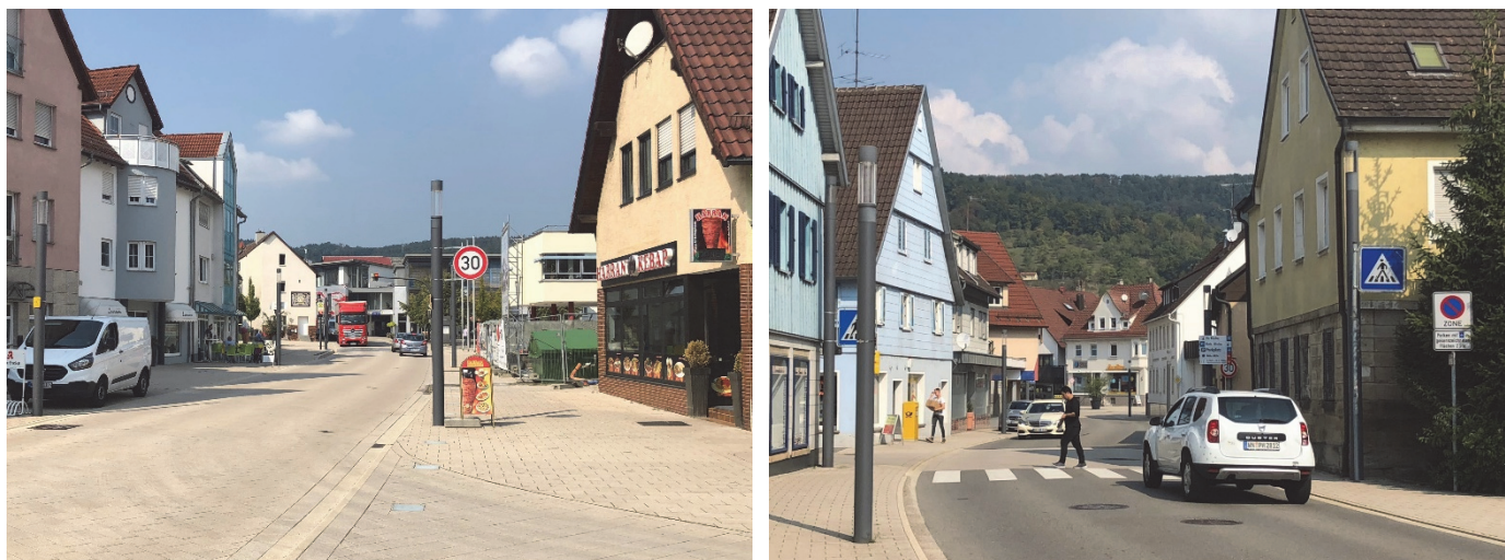
Bilder 9 und 10 | Straßenverkehrsrechtliche Regelungen: Geschwindigkeitsbeschränkung auf 30 km/h im gesamten umgestalteten Abschnitt, Haltverbotszone im einheitlich gestalteten zentralen Abschnitt der Ortsmitte, eingeleitet am Beginn der engeren Bauflucht (Höhe Einmündung Steinhaldenweg, siehe Bild 10)
