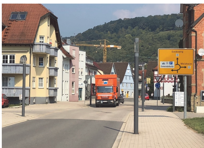
Bilder 34 bis 35 | Kreisverkehrszufahrten: Fahrbahnplasterungen in allen Zufahrten des Minikreisverkehrs unterstützen anstelle von Fußgängerüberwegen die Überquerbarkeit für Zufußgehende, ohne diese zu priorisieren und machen den Knotenpunkt gleichzeitig zum markanten Eingang in die enger bebauten Ortsmitte
