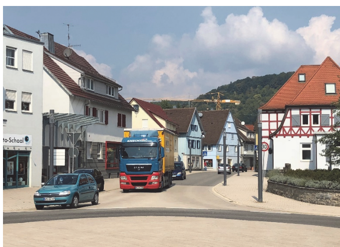
Bilder 34 bis 35 | Kreisverkehrszufahrten: Fahrbahnplasterungen in allen Zufahrten des Minikreisverkehrs unterstützen anstelle von Fußgängerüberwegen die Überquerbarkeit für Zufußgehende, ohne diese zu priorisieren und machen den Knotenpunkt gleichzeitig zum markanten Eingang in die enger bebauten Ortsmitte
