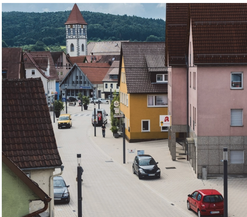
Bild 11 | Straßenraumgestaltung: in Anlehnung an das sog. Shared Space-Prinzip sind Fahrbahn und Seitenräume nur „weich“ separiert, das Gesamtbild wirkt sehr einheitlich
