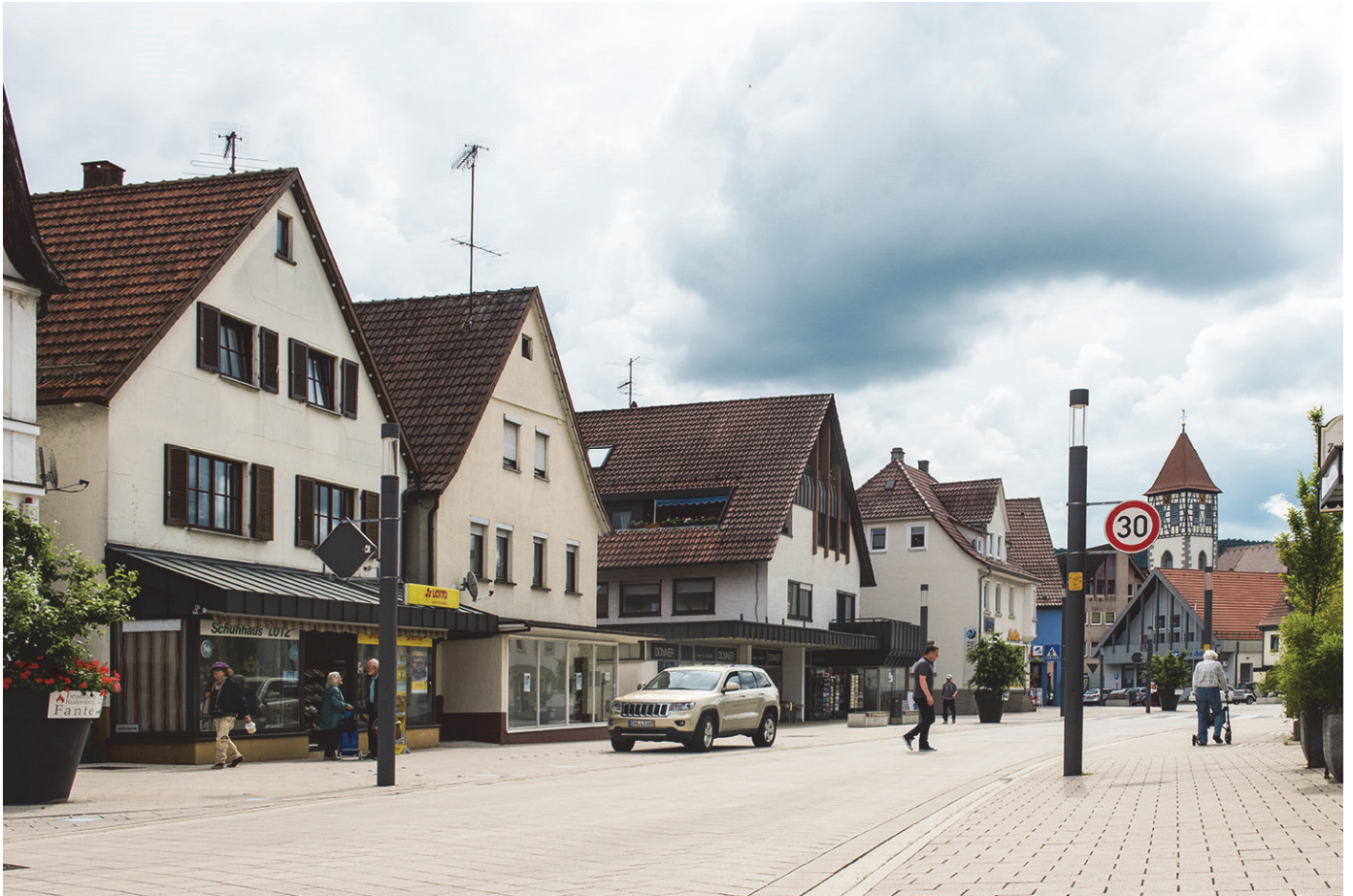
Bild 1 | Die Ortsdurchfahrt im Ortskern nach dem Umbau: weiche Separation von Fahrbahn und Seitenräumen mit einheitlich wirkenden Oberflächenmaterialien, Gestaltung in Anlehnung an das sog. Shared Space-Prinzip
