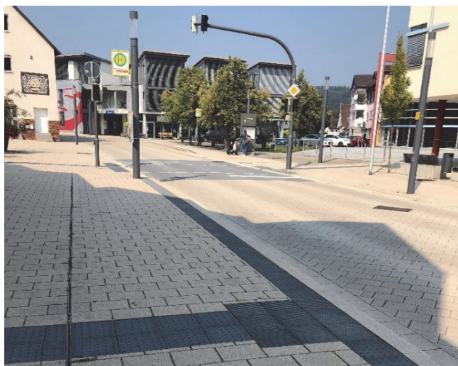
Bilder 21 bis 23 | Gesicherte Überquerungsstellen: ein Fußgängerüberweg (rechts) und eine Bedarfsampel (unten) ergänzen für unsichere und sehbeeinträchtigte Zufußgehende das Angebot, die „weich separierte“ Fahrbahn im gesamten Abschnitt frei zu überqueren
